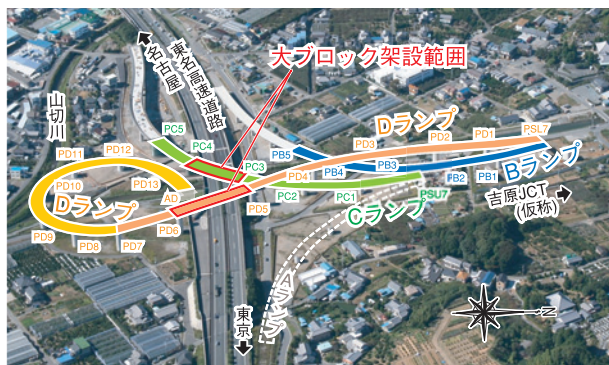
本工事着工前の尾羽JCT付近
