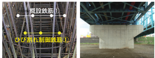
ひび割れ制御鉄筋の配置(柱部) 完成写真(P6橋脚)
