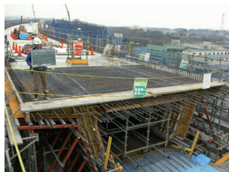
b) 鉄筋、PC組立完了
