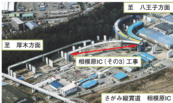
写真1 さがみ縦貫道 相模原IC全景
