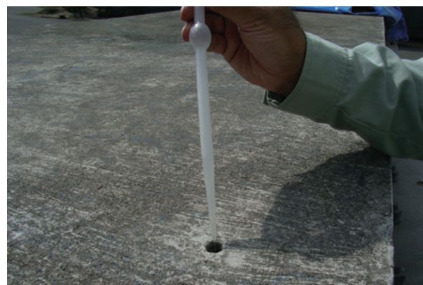
写真5 剥離部への注水状況
