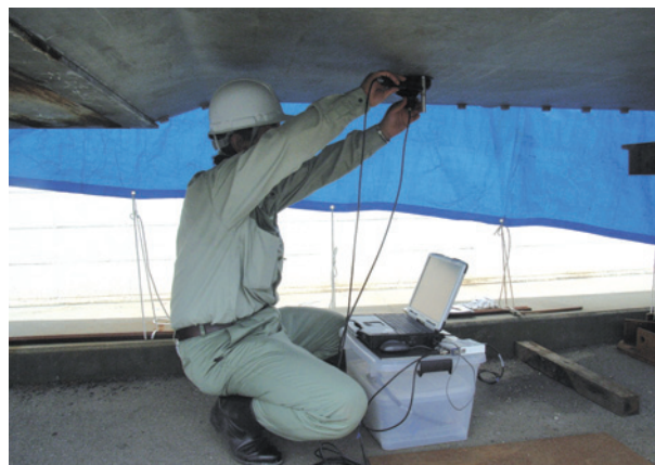
写真3 打音検査風景
