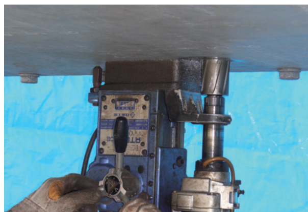
写真4 底鋼板の削孔状況
