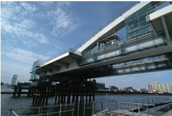
写真6 第2回送出し状況
