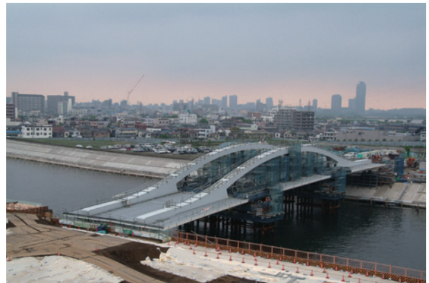
写真7 送出し架設完了
