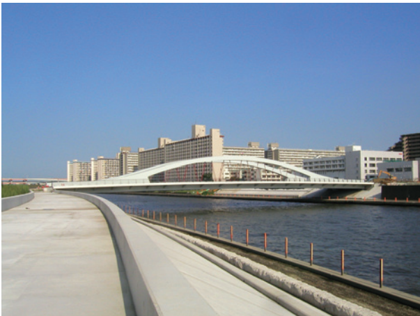
写真1 新豊橋完成写真
