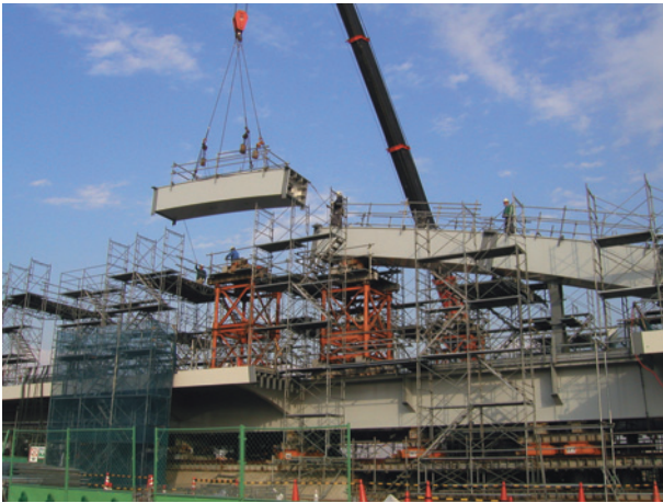
写真4 アーチリブ架設状況
