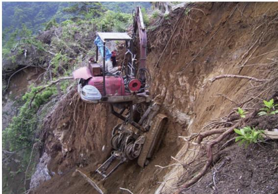
写真3 耐風索アンカー施工状況
