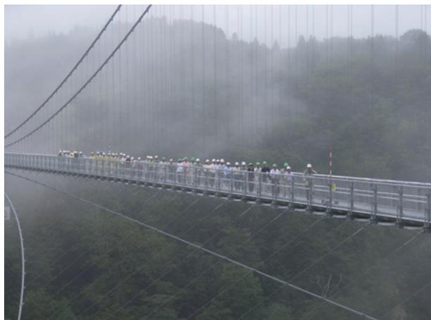
写真2 振動試験状況
