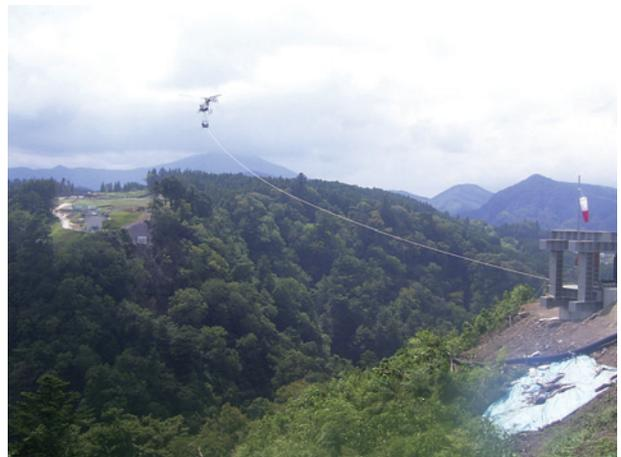
写真4 ヘリコプタによるパイロットロープ張り渡し
