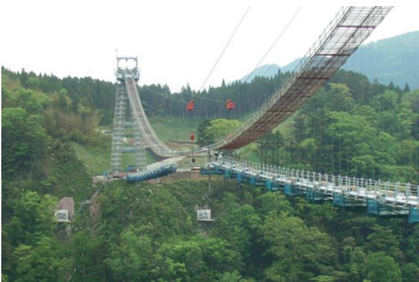
写真6 桁架設状況
