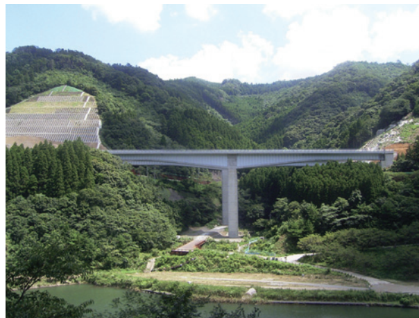
写真2 橋梁全景(手前：上り線、奥：下り線)
