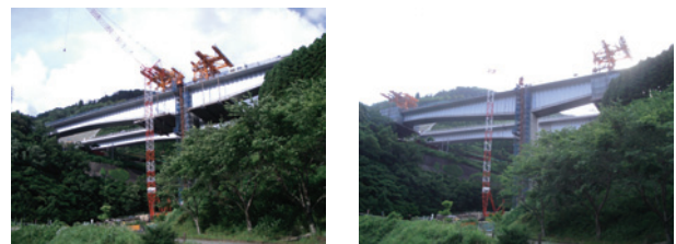
写真1 移動作業車による吊支保施工時のたわみ調整
