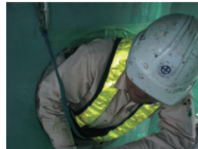
写真4 橋脚点検孔通過状況
