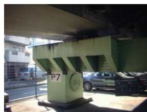
写真25 縁端拡幅設置状況
