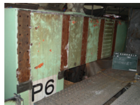
写真34 縁端拡幅装置撤去完了
