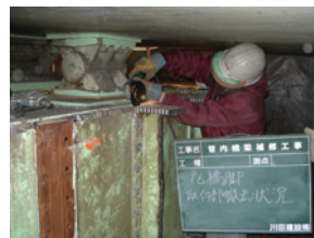
写真32 グラインダーによる除去状況
