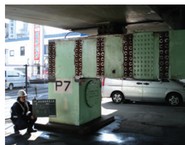
写真35 撤去完了(全景)
