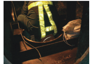
写真5 橋脚内部状況
