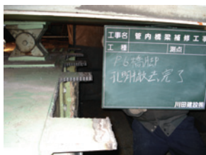
写真31 孔明機械による切断完了
