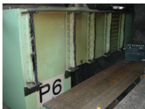
写真29 ガス切断完了
