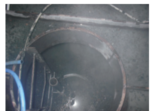
写真11 ウォータージェット はつり完了状況
