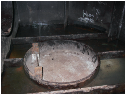
写真9 中詰めコンクリート充填状況
