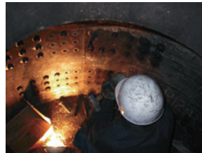
写真22 橋脚内からの打込高力ボルトの打込状況
