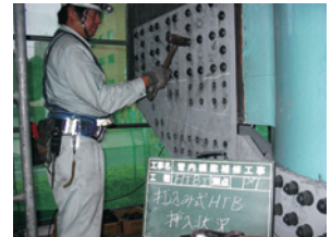
写真23 落橋防止装置部分の打込式高力ボルトの打込状況
