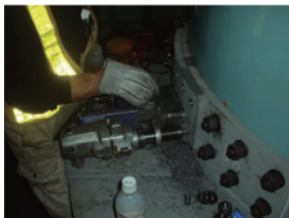
写真20 円柱部外側孔明状況
