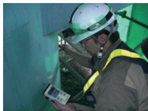
写真3 柱面計測状況
