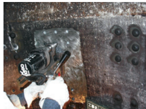
写真21 円柱部内側孔明状況
