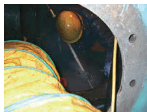
写真10 ウォータージェット はつり状況
