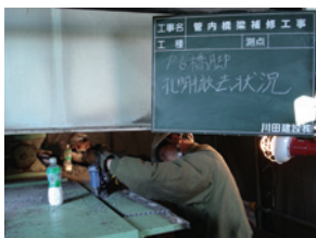
写真30 孔明機械による切断状況
