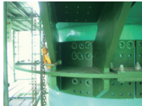
写真18 現場孔明確認
