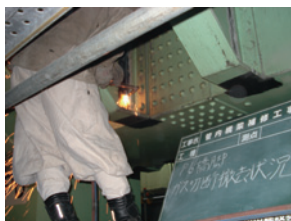
写真27 ガス切断状況
