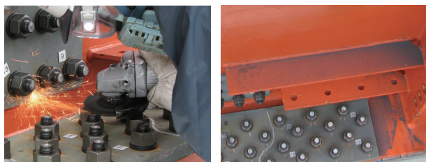
写真4 ディスクグラインダ処理と飛散した鉄粉
