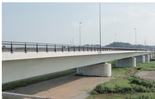
写真1 橋体工完成写真
