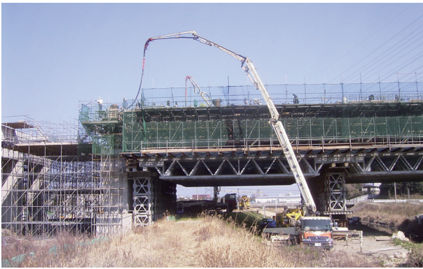
写真1 ブロック⑥上スラブ打設状況
