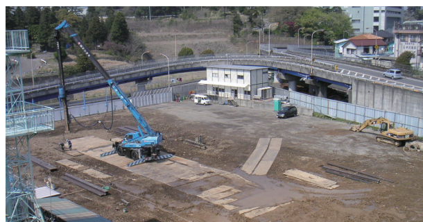
山留工事状況
