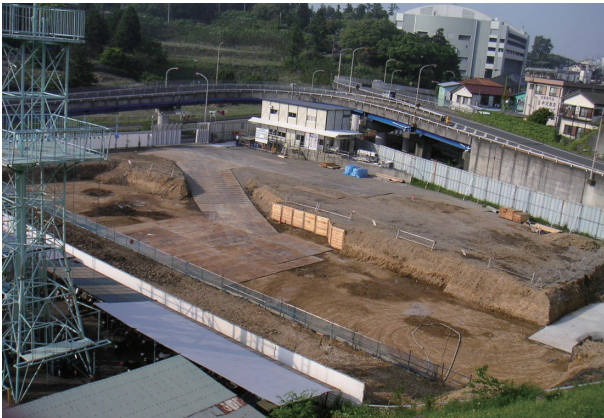
先行根伐工事完了
