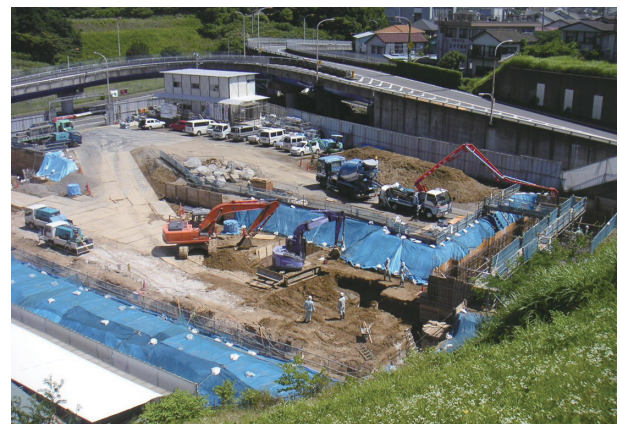
根伐工事状況
