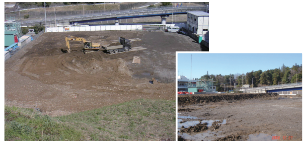
盛土搬出状況
