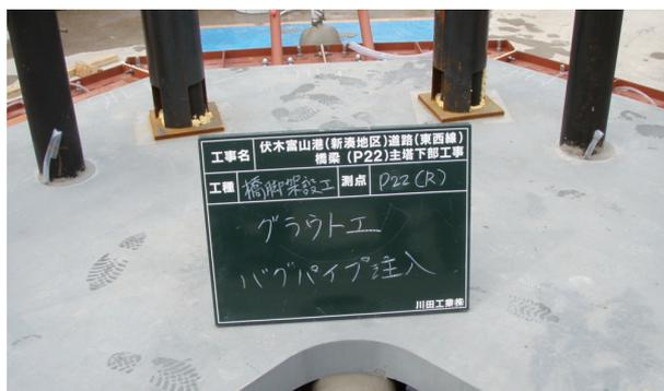
写真7 バグパイプ内打設完了
