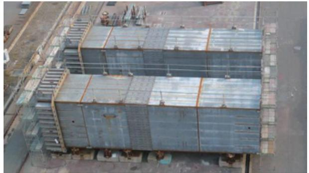
写真3 基部ブロック仮組立完了
