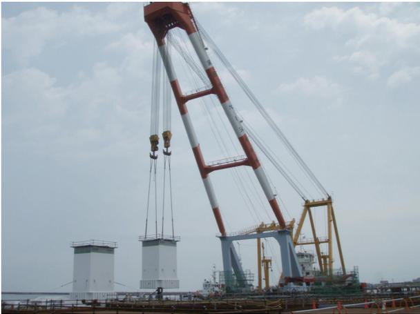
写真 9 塔基部の架設
