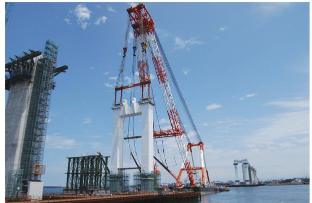
写真 12 塔下部の架設
