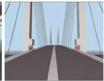
④タワーリンク脱落による主構の沈下
