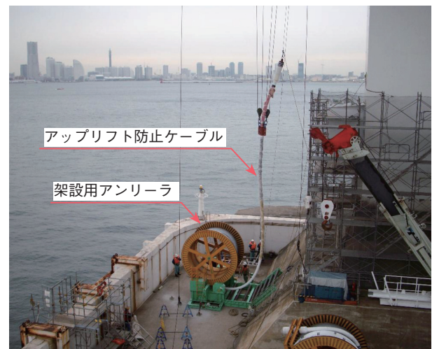
写真5 アップリフト防止ケーブルの架設
