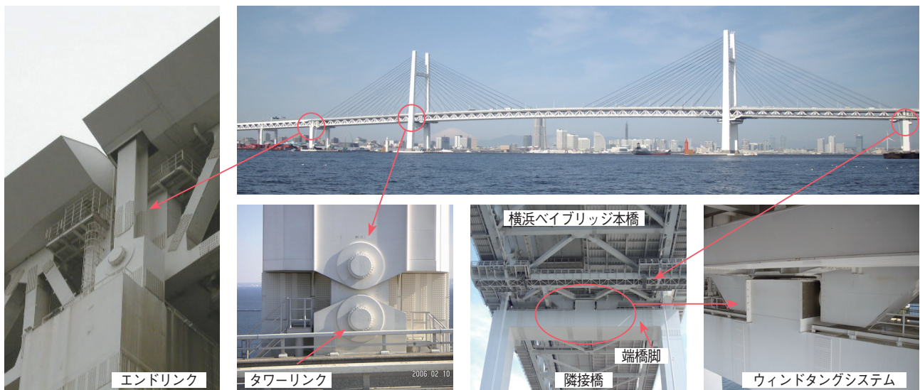
写真1 横浜ベイブリッジの構造概要図
