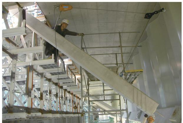
写真 5 ストラットのアンカーバー差し込み状況
