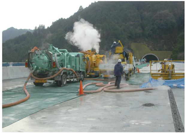
写真7 床版打継ぎ部のコンクリートはつり状況
