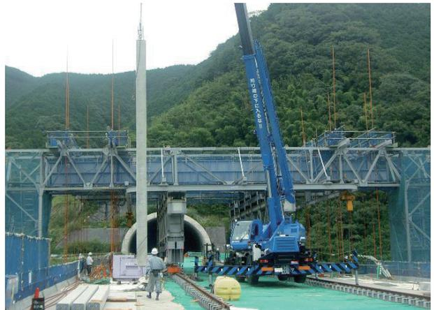
写真 3 ストラット架設状況
