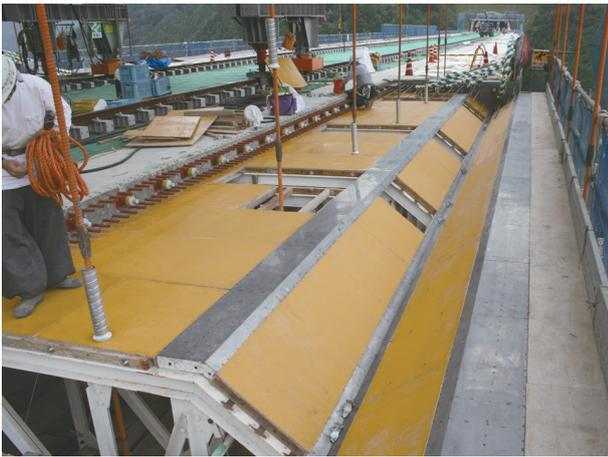
写真6 拡幅床版型枠状況
