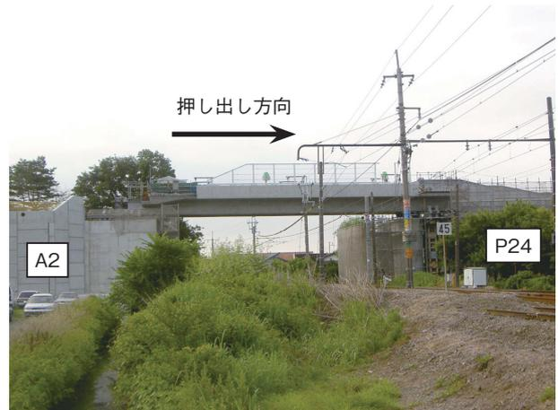
写真3 上り線架設完了写真（側面）
