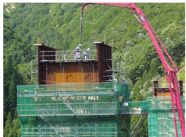
写真1 剛結部施工状況
