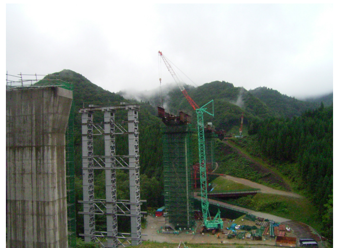
写真 3 P5 張り出し架設状況
