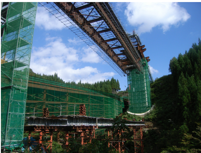
写真 2 一括吊り上げ架設状況
