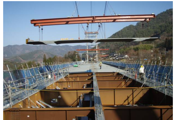
写真11 SCデッキパネルの架設
