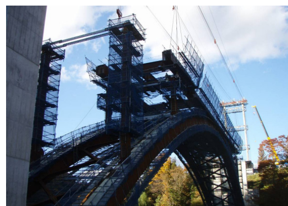
写真10 補剛桁架の架設
