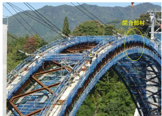
写真8 アーチリブの閉合架設
