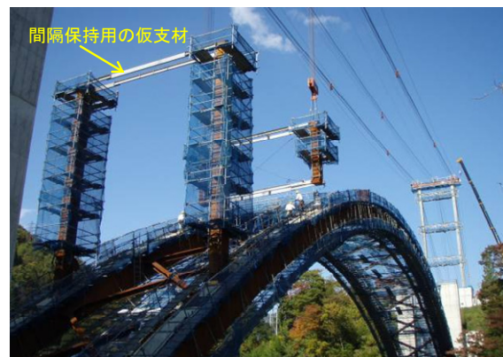
写真9 支柱の架設
