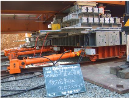
写真2 後方台車設備 (クビスジャッキ使用)
