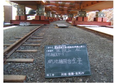
写真4 地組架台配置状況
