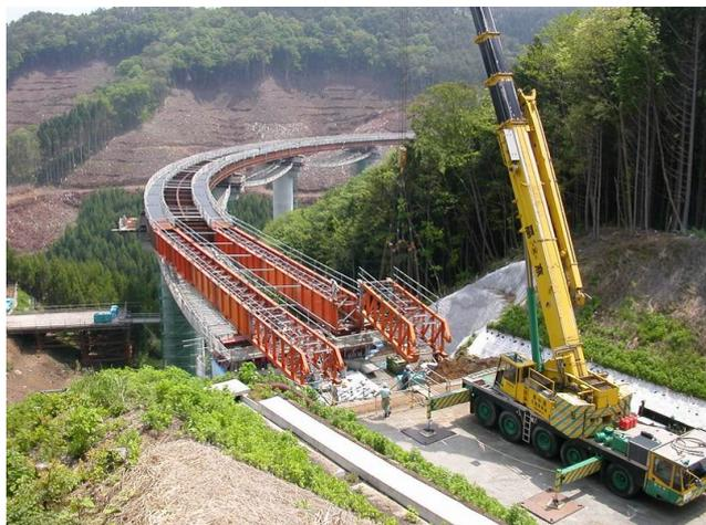
写真11 A1到達後手延べ桁撤去併用送り出し
