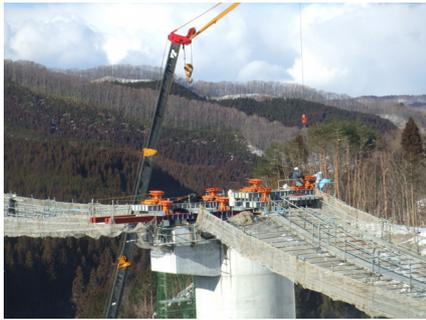
写真5 P5橋脚上での送り出し設備の組立
