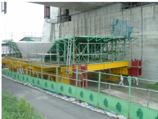
写真 2 主桁型枠（緑）とトラベラー底版（黄）
