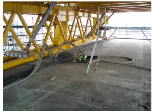
写真 3 トラベラー下段作業床 排水設備
