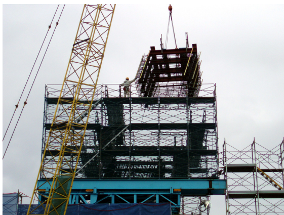
写真 1 プレファブ鉄筋架設
