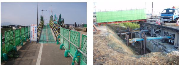
写真2 仮歩道設置状況
