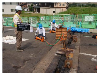
写真 4 橋梁拘束解放
