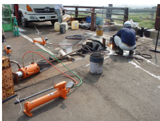
写真 3 伸縮装置接触部撤去
