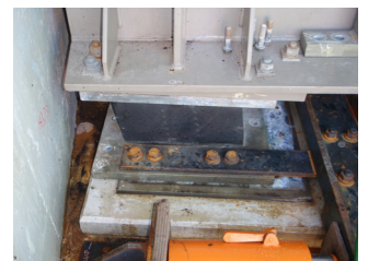
写真 7 支承ゴム変形解放
