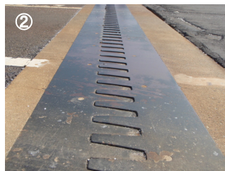
伸縮装置の接触・段差
