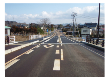
完成(A1橋面)
