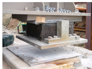
写真9 A1 桁扛上状況 (下部工付きブラケット工法)
