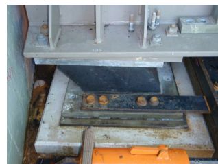
写真 6 支承ゴム変形解放
