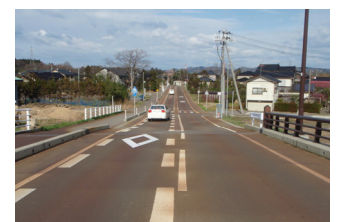
着手前(A1橋面)
