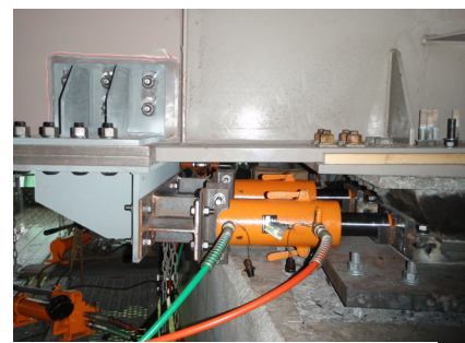
写真 8 支承ゴム異常変形解放治具
