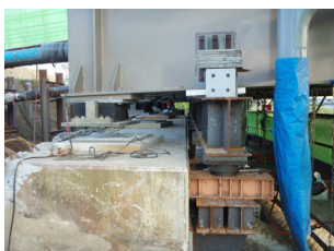
写真9 A1 桁扛上状況 (下部工付きブラケット工法)
