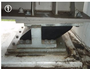
支承ゴムの異常変位
