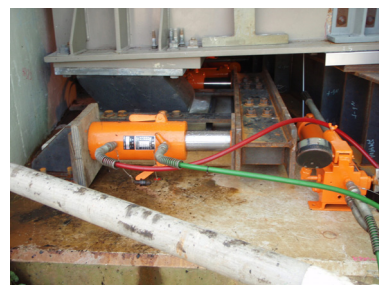
写真 5 支承ゴム異常変形解放治具
