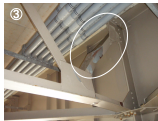
対傾構部材の座屈
