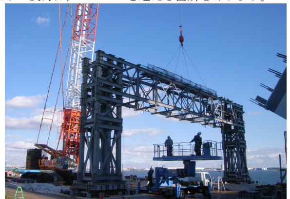
＜ベント部材設備組立状況＞
