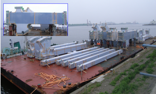
＜海上輸送し、岸壁に横付けされたトラス部材＞
