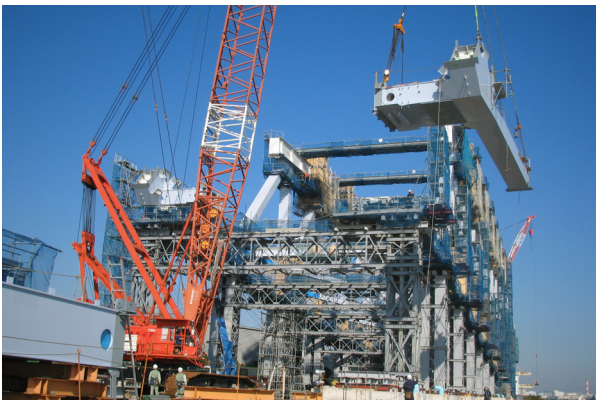
＜トラス部材（下弦材）の地組立状況＞
