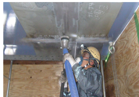
＜バキューム方式によるブラスト状況＞
