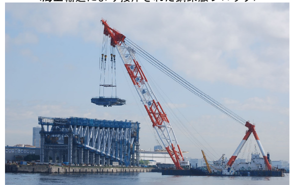
＜1400t吊FCによる鋼床版ブロック地組立状況＞
