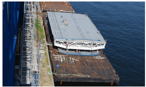
＜海上輸送により接岸された鋼床版ブロック＞
