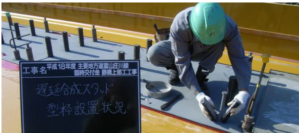
遅延合成スタッドの施工状況
