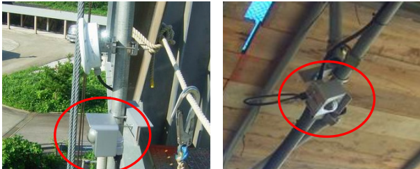
監視カメラ設置状況 (A1 鉄塔下部、ウィンチ小屋)
