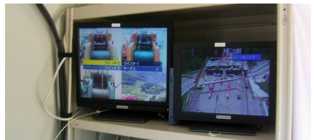
監視カメラからの映像を写したテレビモニター
