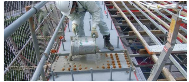
主桁添接部の対処
