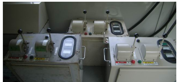
遠隔操作室内、操作レバー
