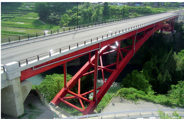
藤橋 完成写真
