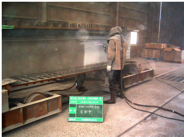
製作工場による金属溶射状況
