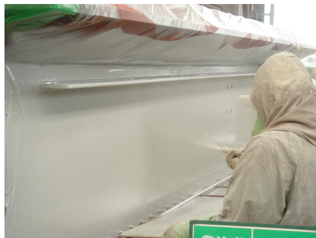
製作工場によるフッ素系塗装状況
