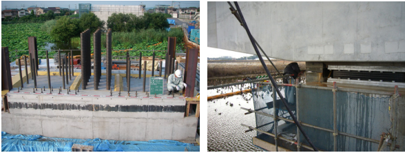
仮沓設置状況
