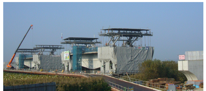
野々池高架橋張出し架設状況
