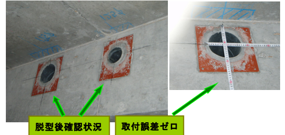
型枠脱型後確認状況
