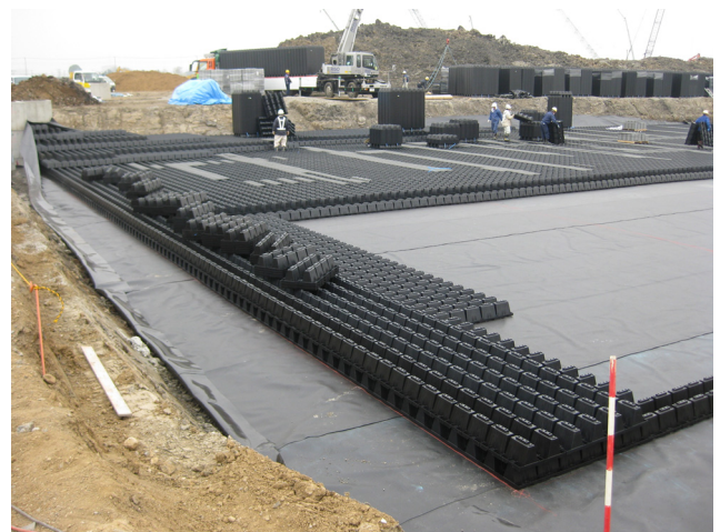
貯留槽組み立て状況
