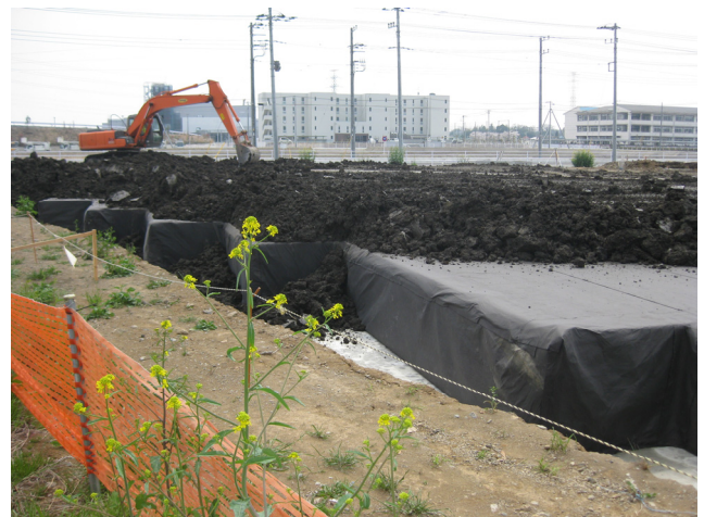
保護シート巻き完了後，埋め戻し状況
