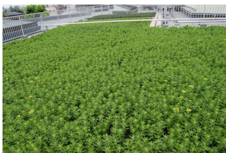
←屋上緑化 墨田特別支援学校
