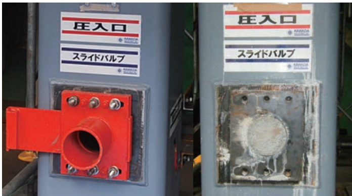
圧入口 (圧入前)
