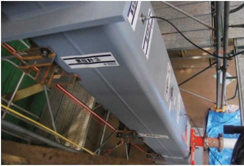
圧入施工実験状況
