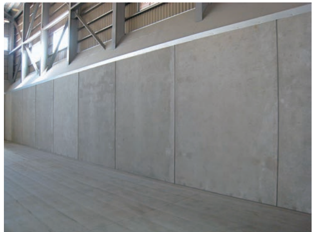
写真3 腰壁建方完了
