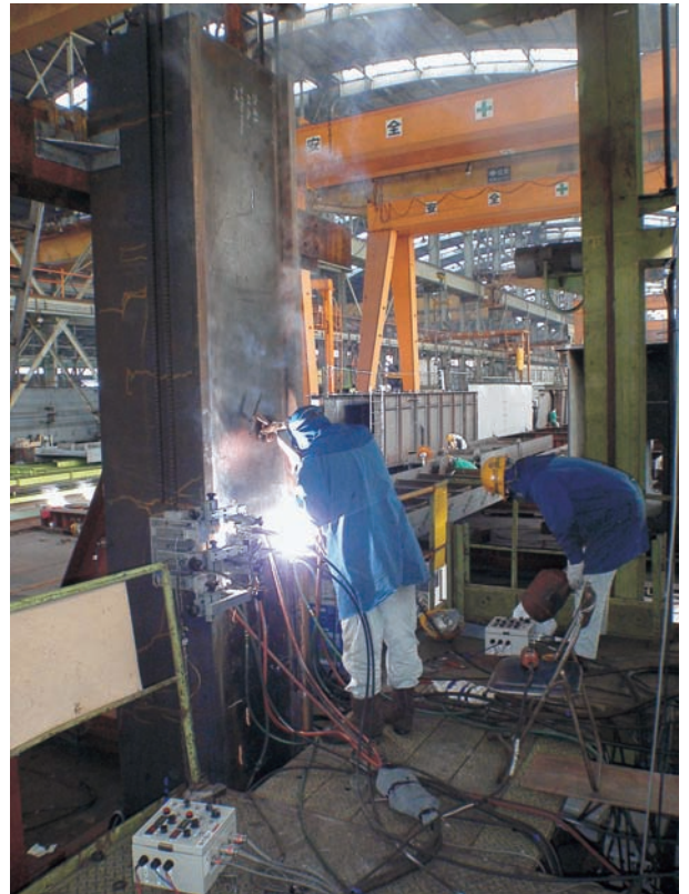
溶接作業風景
