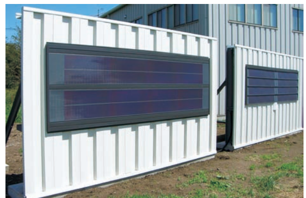
写真1 壁面ソーラーパネル
