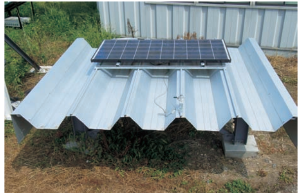
写真2 屋根ソーラーパネル
