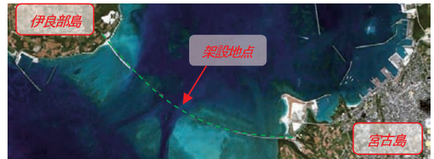
架設地点航空写真
