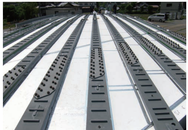
中空部型枠（発泡スチロール）敷設完了時
