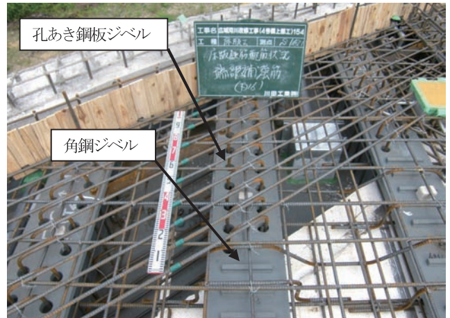
孔あき鋼板ジベルと角鋼ジベル
