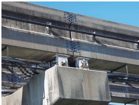
大阪モノレールP C軌道桁
