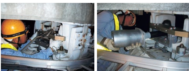
支圧板設置状況
