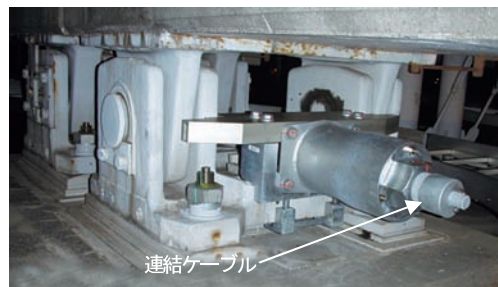
落橋防止装置設置完了
