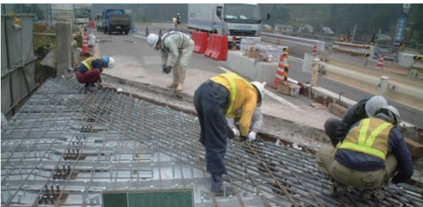
写真2 斜角が厳しい条件でのSCデッキによる取替え事例
