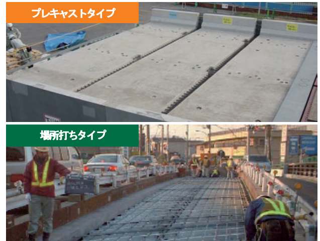
写真3 プレキャストタイプと場所打ちタイプ
