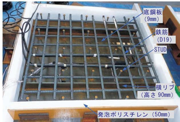
写真6 SCデッキ試験体(コンクリート打込み前)
