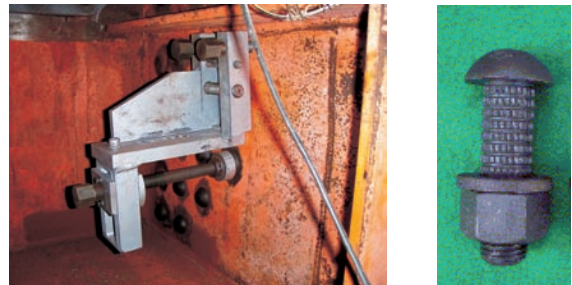
写真6 無騒音打ち込み治具と打込みボルト
