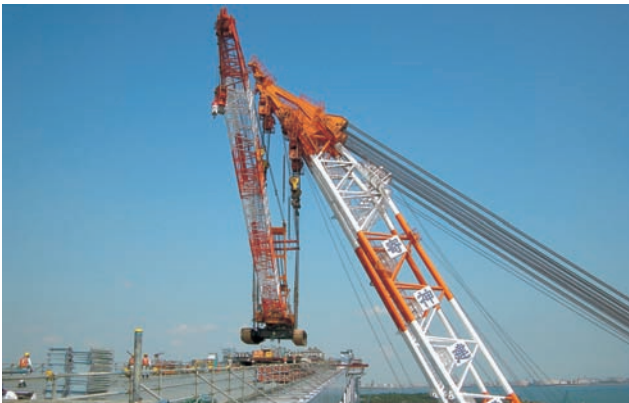
写真17 架設クレーンの桁上搭載状況
