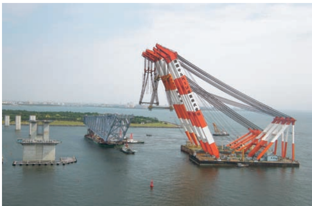
写真12 架設地点入域状況(若洲側)
