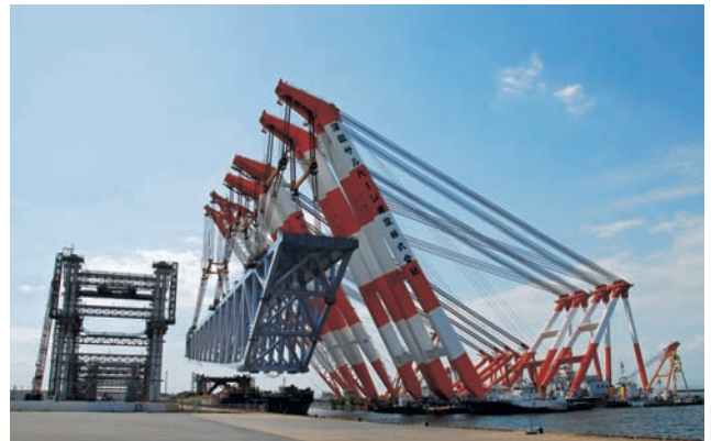
写真8 台船搭載状況（若洲側）
