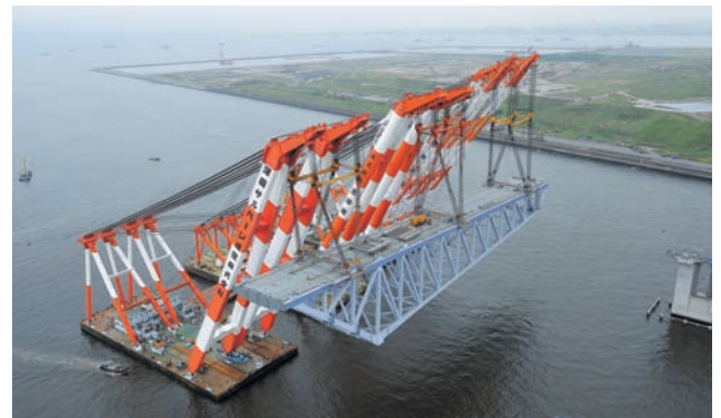
写真14 架設状況(中防側)
