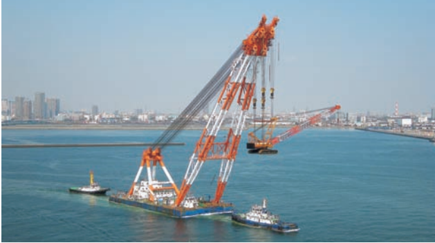
写真16 架設クレーンの吊曳航状況
