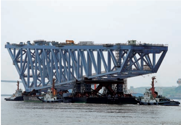
写真11 台船による海上輸送(中防側)
