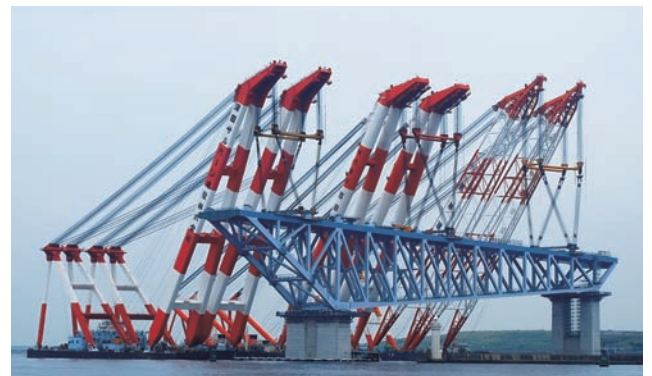
写真15 架設完了(中防側)
