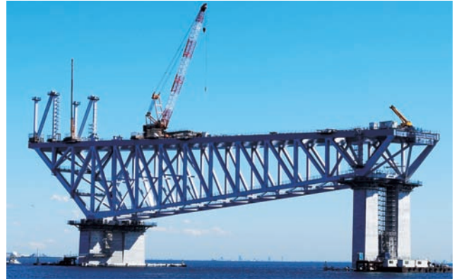
写真18 上部トラス単材架設状況（中防側）
