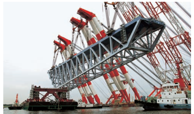
写真13 水切り状況(中防側)
