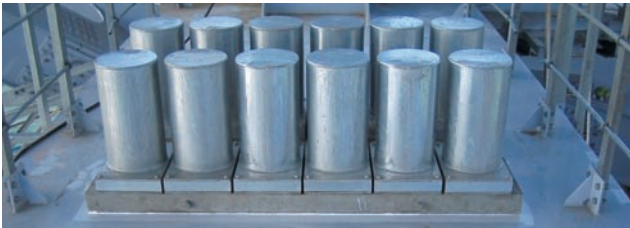
写真 20 端部ケーブル上端定着部 (完成時)
