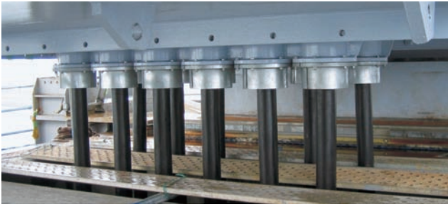
写真 19 端部ケーブル配置 (施工中)
