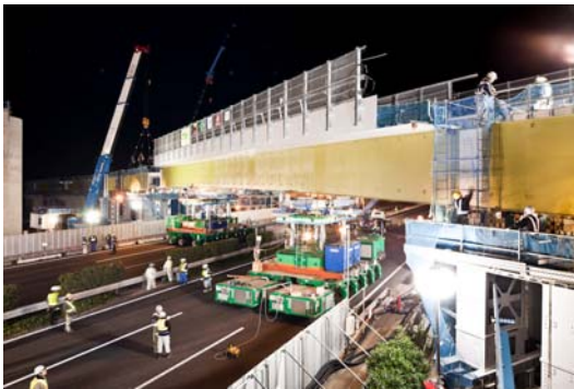
桁架設完了
