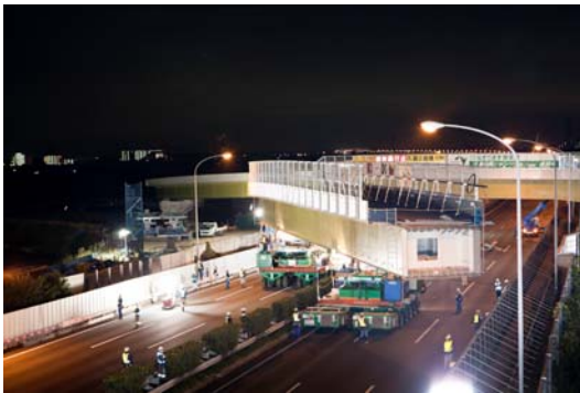
東北自動車道上運搬状況
