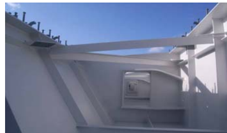
開断面箱桁内の写真
