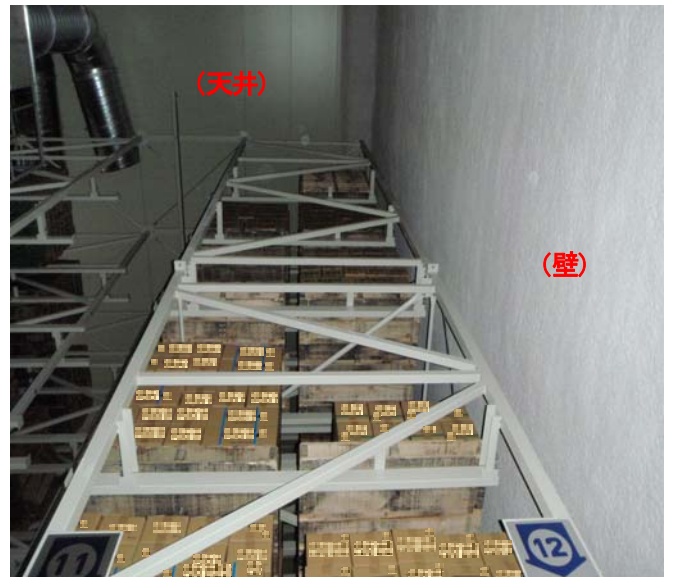
冷凍ラック倉庫内観 (見上げ)
