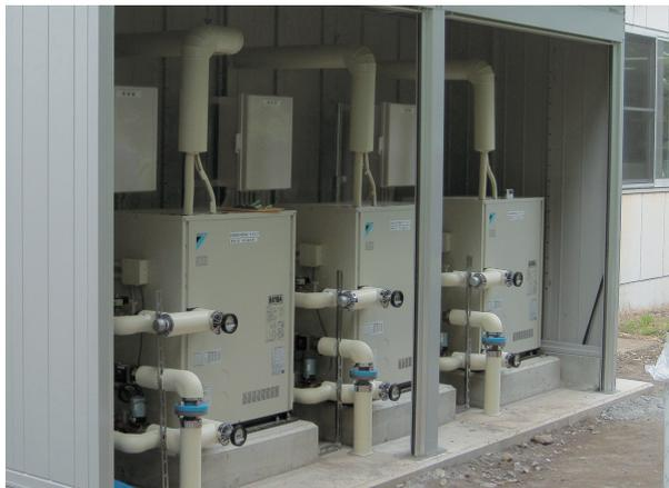
写真9 新設した地中熱HPの一部
