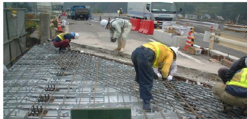
写真1 斜角が厳しい条件でのSCデッキによる床版取替え事例
