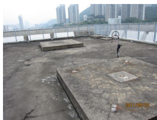
写真2 施工前の屋上
