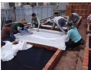
写真3 施工中の写真
