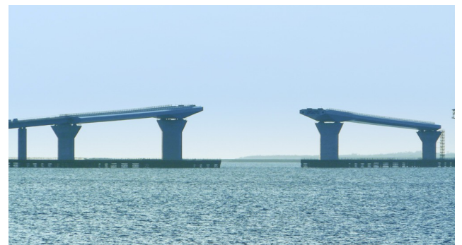
写真11 その1工事架設完了状況
