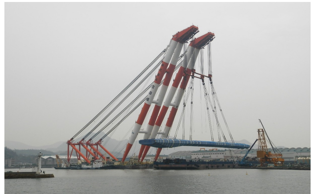
写真8 浜出し作業状況
