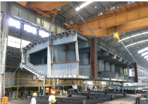
写真1 大型部材の製作状況
