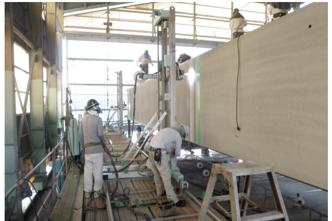
写真5 溶射作業状況
