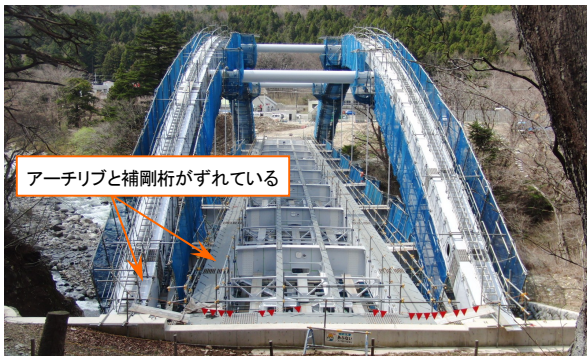
アーチリブと補剛桁のずれ
