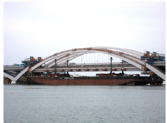
一括吊り上げ架設状況
