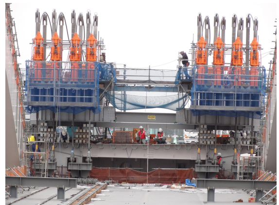
吊り上げ設備（吊り上げ架設中）
