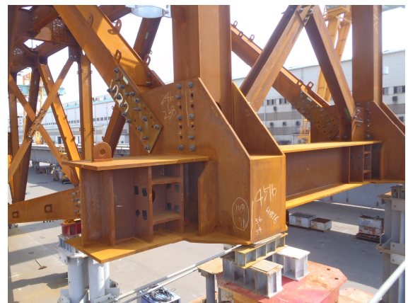
適用部位 端支点部下弦材および端横支材
