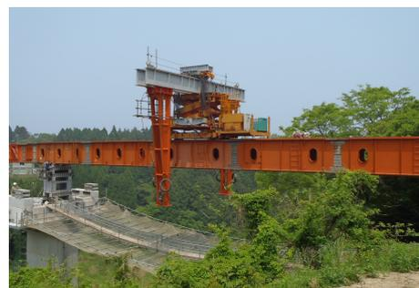
写真5 架設門構移動状況
