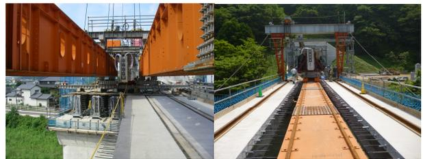
写真4 主桁引出状況の比較（左：ダブルガーダー工法
