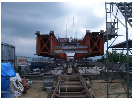
写真3 架設桁移動状況
