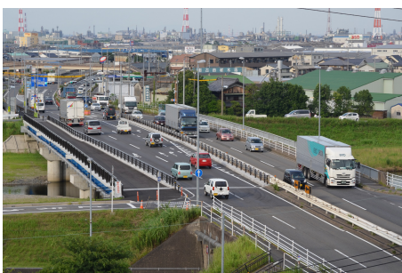
上り線施工完了
