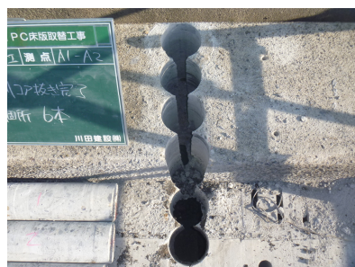
カッター切断不可部の連続コア削孔
