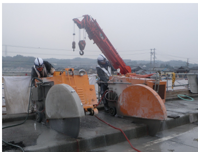
大型ブレードによる切断
