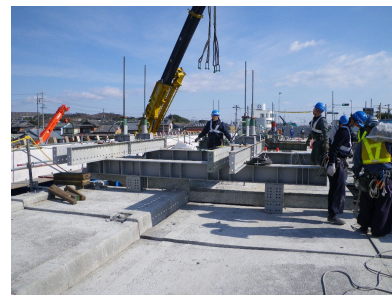
ジャッキアップ
